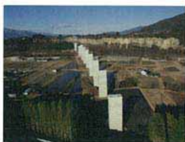
飯島町本郷付近の工事状況
