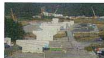
海山IC付近の工事状況
