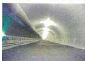
高丸山トンネル工事状況
