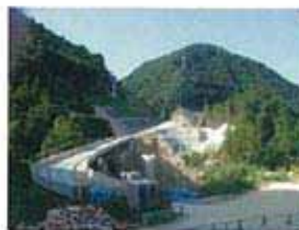
鳳来IC(仮称)付近工事状況
