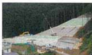
尾鷲北IC付近の工事状況
