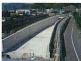
昭府地区工事状況
