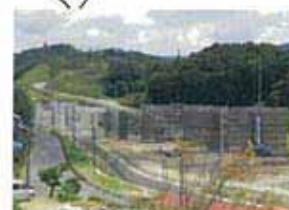
引佐IC(仮称)付近工事状況
